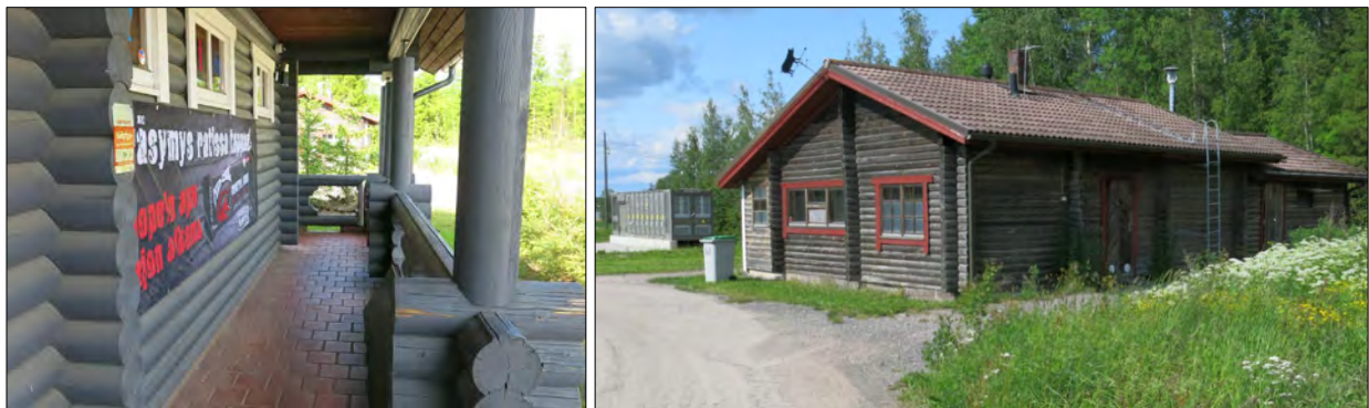
Kuva 3.5 Rakennukset ovat kevytrakenteisia hirsirakennuksia 1990-luvulta. Taustalla akkuvarasto.
