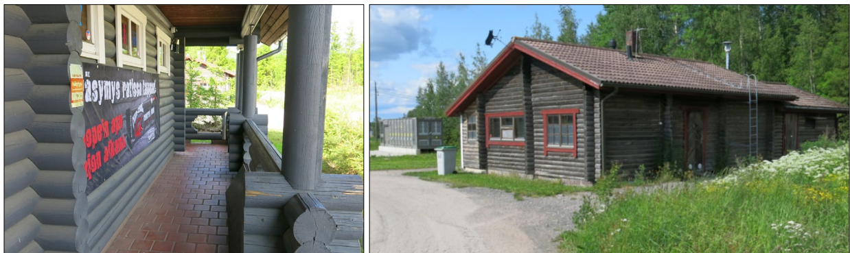
Kuva 3.5 Rakennukset ovat kevytrakenteisia hirsirakennuksia 1990-luvulta. Taustalla akkuvarasto.
