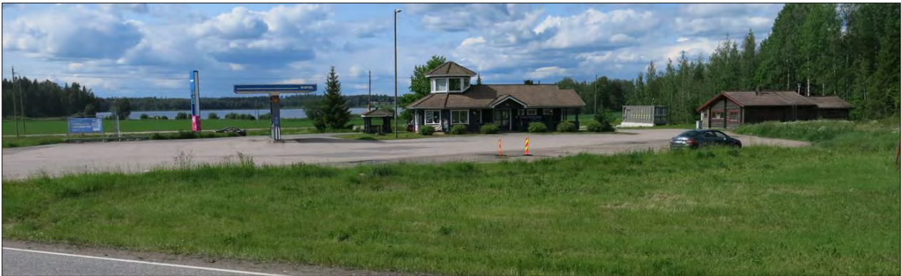
Kuva 3.4 Alueella on huoltoasema, kahvila/myymälä, piharakennus, akkuvarasto ja muuntamo.
