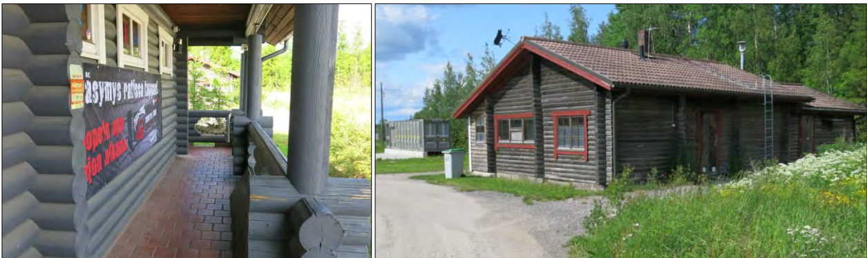
Kuva 3.5 Rakennukset ovat kevytrakenteisia hirsirakennuksia 1990-luvulta. Taustalla akkuvarasto.
