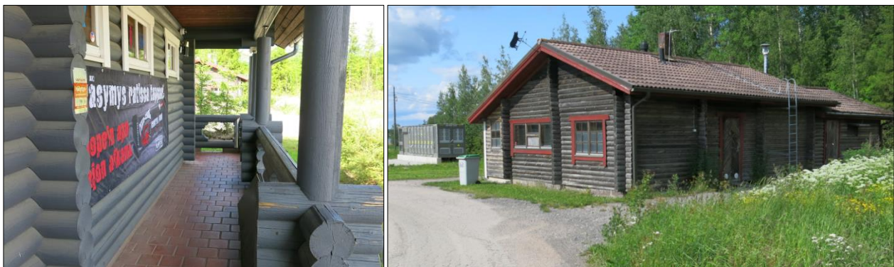
Kuva 3.5 Rakennukset ovat kevytrakenteisia hirsirakennuksia 1990-luvulta. Taustalla akkuvarasto.
