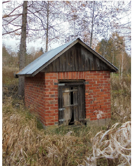
Kuva 3.8 Kaava-alueella sijaitseva vanha kaivorakennus.
