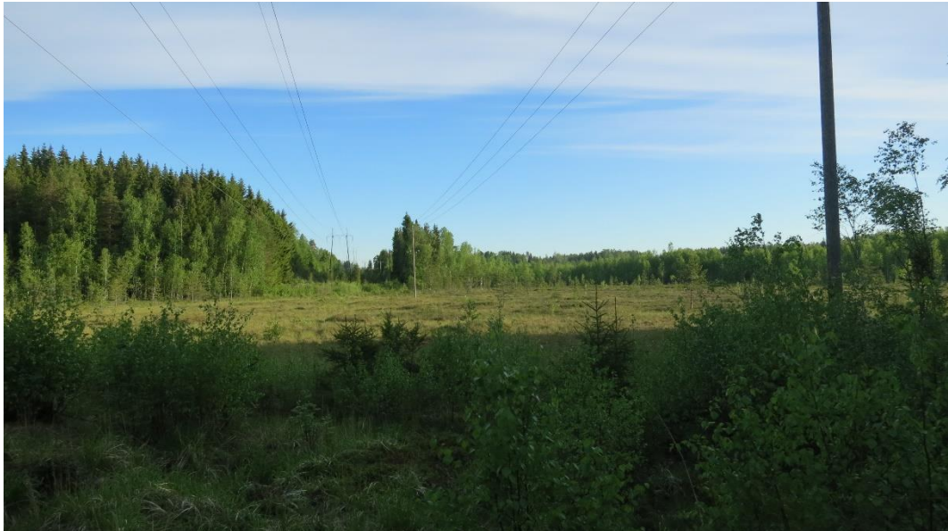
Kuva 22. VE1 kulkee Natura-alueen Koivumäki-Luutasuo (FI0323001) avoimen nevasuon yli olemassa olevan voimajohdon vieritse. Tällä kohtaa voimajohto ylittää myös luonnonsuojelun Sirkkosuon läntinen luonnonsuojelualue. Kuvaussuunta pohjoiseen.
